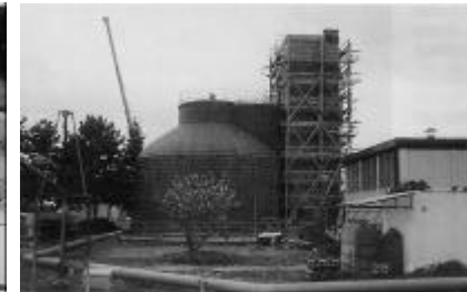
Treppenturm (eingewölbt für Sanierung) und Faulbehälter
