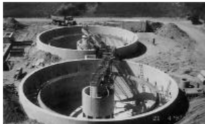
Nachklärbecken im Bau
