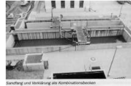
Sandfang und Vorklärung als Kombinationsbecken
