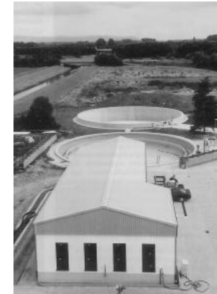
Sandfang und Vorklärung als Kombinationsbecken
