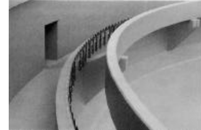
Das bestehende Regenüberlaufbecken wurde komplett saniert
