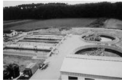
Belebungsstufe mit Nachklärbecken
