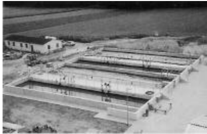
Belebungsbecken nach Fertigstellung
