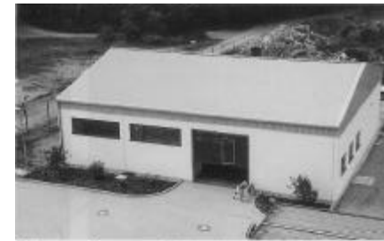
Schlammentwässerungsgebäude (errichtet im alten Belebungsbecken)
