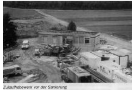
Zulaufhebwerk vor der Sanierung
