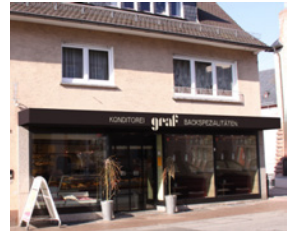
Die verkleinerte und in das Vordach integrierte Anlage passt sich zurückhaltend und selbstverständlich in das Gesamtbild ein.
