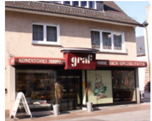
Eine große Werbeanlage über dem Eingang dominiert die Fasadengestaltung.
