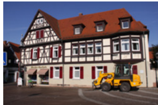
Kombination aus traufständig und giebelständig in einem Gebäude
