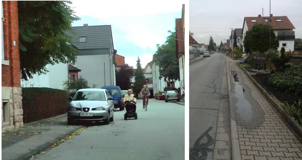
Abbildung 16: Nutzung des Gehweges für Personen mit Gehhilfen nicht mehr gewährleistet (Alexanderstraße) + Pfützenbildung (Siegfriedstraße) aufgrund illegalen Gehwegparkens
